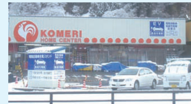
電気自動車の急速充電器を設置したHC湯沢店。設置店舗であることが分かるように、外壁に大きく看板を掲げています。
