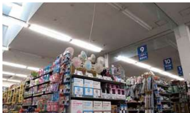
店内の照明を互い違いに点灯し、全体の使用量を削減しました。
