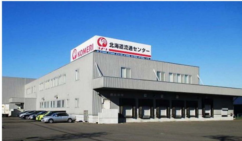
2014年10月稼働 北海道流通センター
