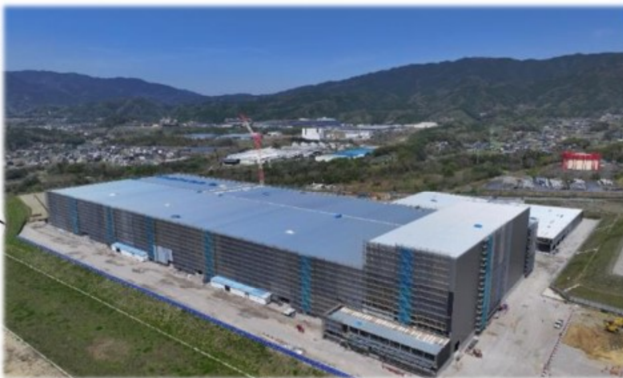
＜新関西流通センター 2026年春稼働予定＞
