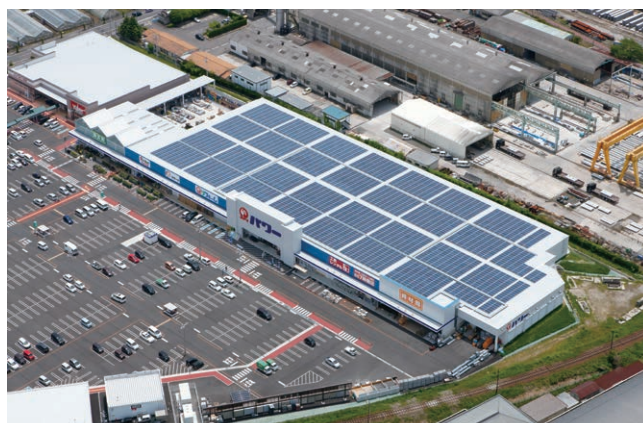
パワー店舗屋上のソーラーパネル
